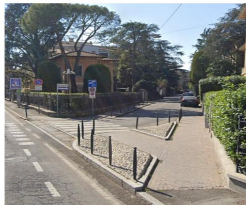
*Riduzione raggio di curvatura con penisola rialzata in intersezione stradale urbana*
